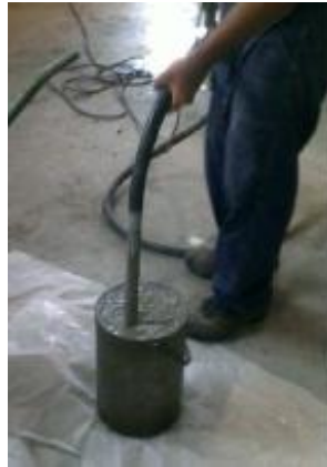
Figura 5. Vibração do betão por agulha vibratória.
