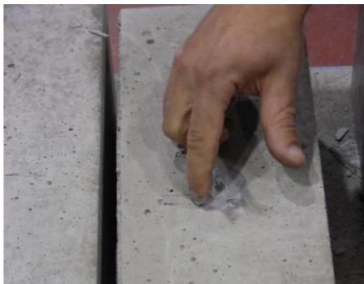
Figura 28. Aplicação do betume polimérico.
